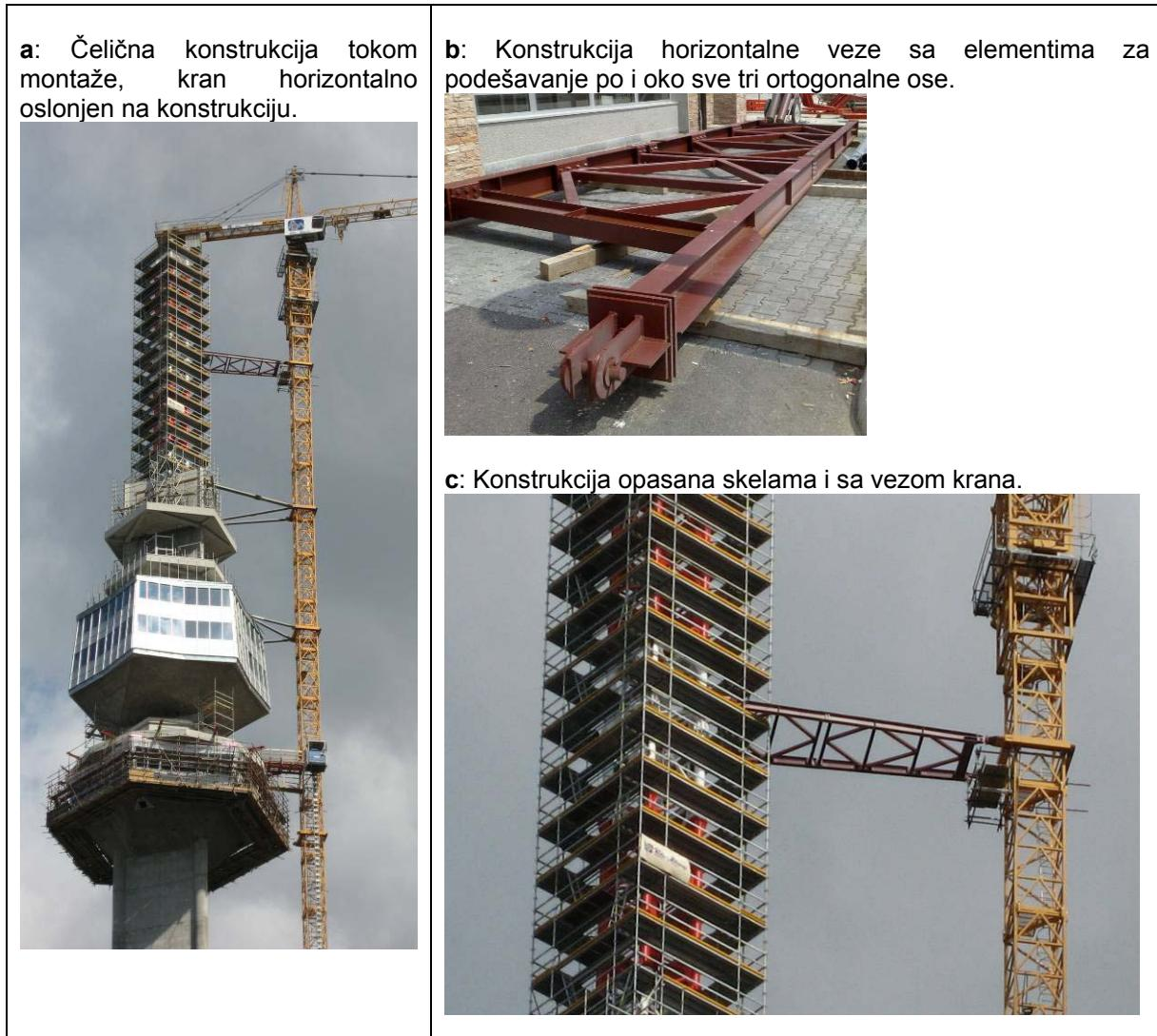
**Slika 7:** Čelični deo konstrukcije tornja tokom montaže.
